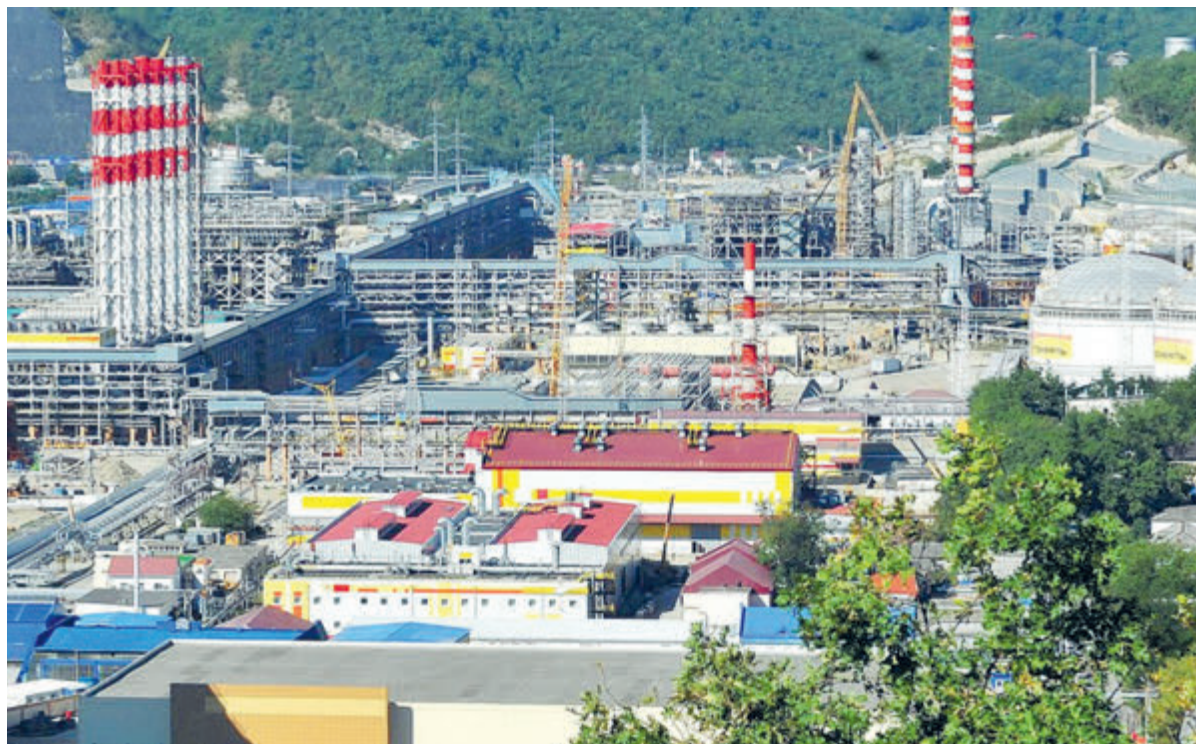
В Туапсе в начале 1950-х годов был возведен новый НПЗ – вместо того, что в войну был эвакуирован в Красноводец.
